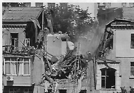
Wybuch butli z gazem w budynku mieszkalnym
